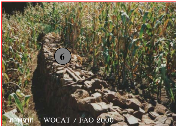
ภาพที่ 12 กำแพงหินที่สร้างขึ้นตาม แนวระดับ ซึ่งต่อไปจะกลายเป็น ชั้นบันไดดิน
