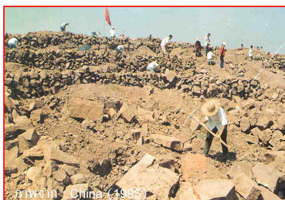
ภาพที่ 15 การก่อสร้าง ชั้นบันไดดินในพื้นที่ที่มีก้อน หินมาก ควรเอาหินมาทำ กำแพงของชั้นบันไดและควร เริ่มจากแนวสูงสุดก่อนเป็น แนวแรกและค่อยๆ ทำแนว ถัดลงมา
