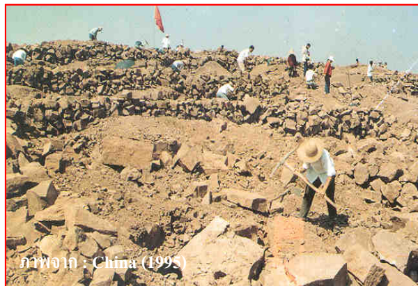
ภาพที่ 18 การก่อสร้าง ชั้นบันไดดินที่มีก้อนหินมาก ควรเอาหินมาทำกำแพงของ ชั้นบันไดและควรเริ่มต้นจาก แนวสูงสุดก่อนเป็นแนวแรก แล้วค่อยๆ ทำแนวถัดลงมา
