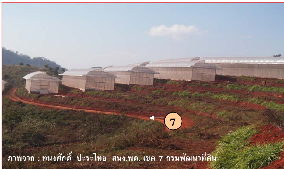
ภาพที่ 5 การสร้างสิ่งก่อสร้างต่างๆ บนชั้นบันไดดินบนพื้นที่ที่มีความลาดเทสูง
