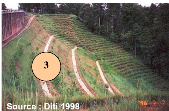
3. คูรับน้ำชายเขาที่ใหญ่ด้านล่างของถนนในภาพเป็นคูรับน้ำชายเขาคอนกรีตรูปร่างคล้ายตัว V สลับกับแถวหญ้าแฝก
