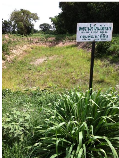
สระน้ำไม่สามารถกักเก็บน้ำได้ เนื่องจากโครงสร้างดินเป็นดินทราย
