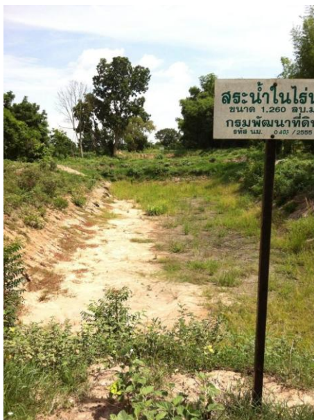
สระน้ำไม่สามารถกักเก็บน้ำได้ เนื่องจากโครงสร้างดินเป็นดินทราย
